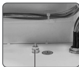
Śruba uziemiająca (PE)
